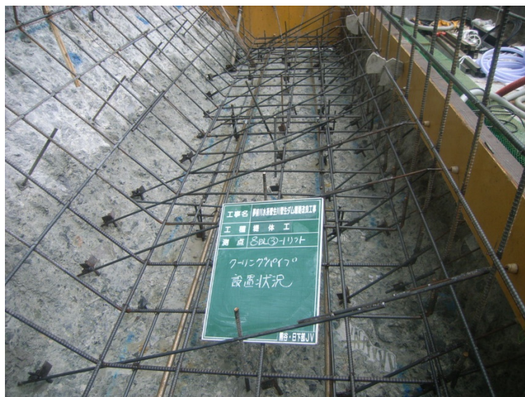
写真-3.3 パイプクーリングの敷設状況
