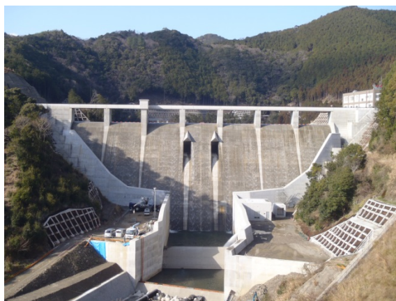
写真-4.5 KM ダム
