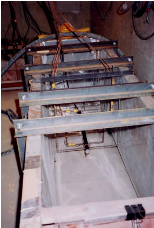
写真-5.1 型枠組立状況
