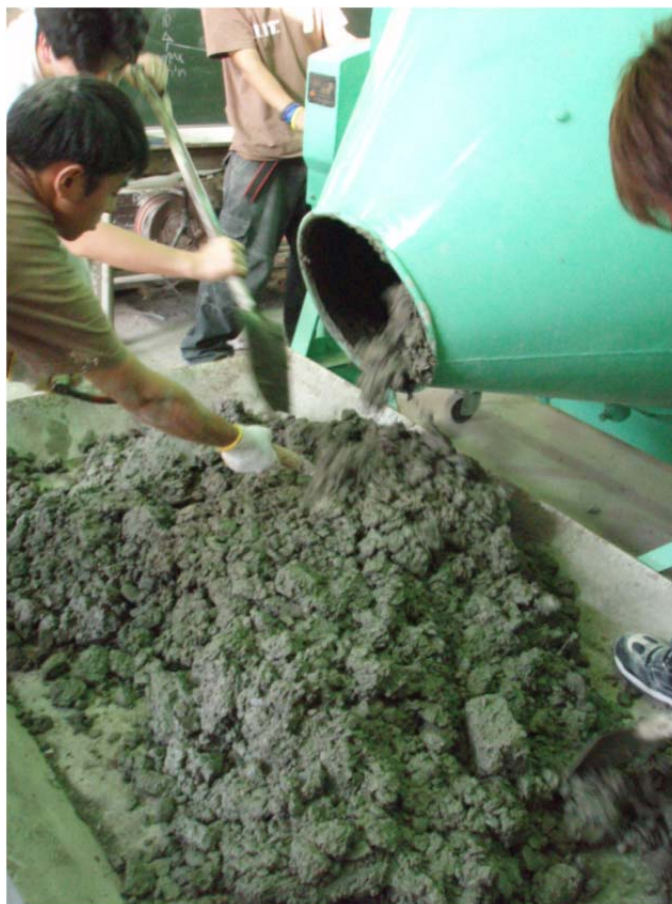
写真-5.5 250 l の傾胴式コンクリートミキサによるフルサイズ骨材を用いた ダムコンクリートの練混ぜおよび排出状況
