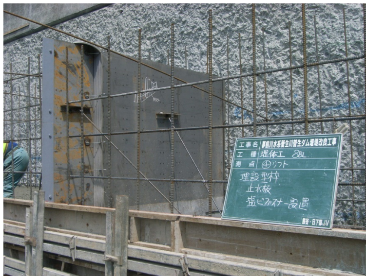
写真-3.2 ブロック分割を行うための鉄板と塩ビファスナーによる施工目地の設置状況
