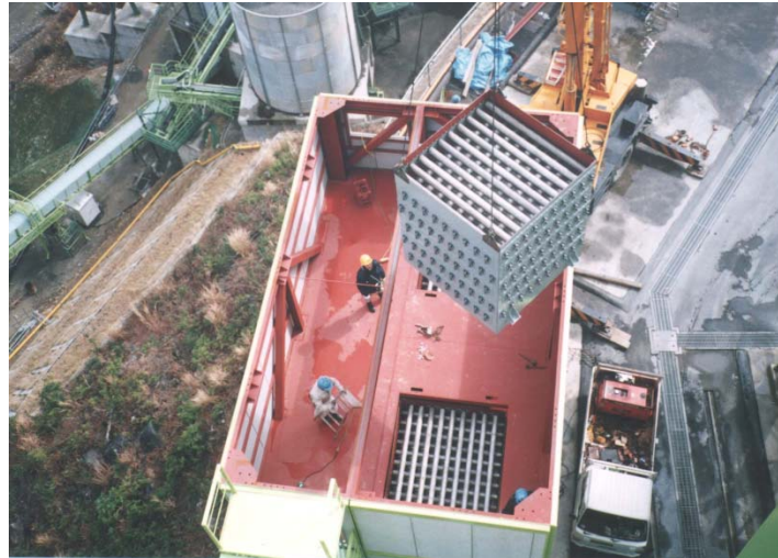
写真-3.7 気化冷却塔の組み立て状況
