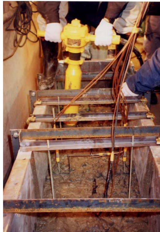
写真-5.2 コンクリートの打設状況
