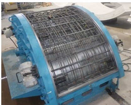
写真 5-6 セグメントの配筋状態
