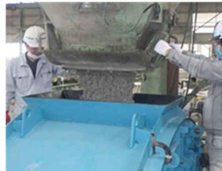
写真 5-7 IBPM コンクリートの型枠への打設
