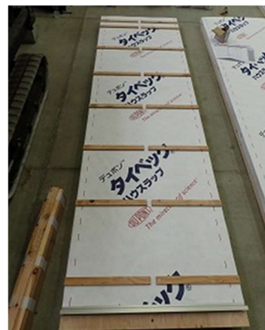
図 3-3-6 横胴縁仕様の状況
