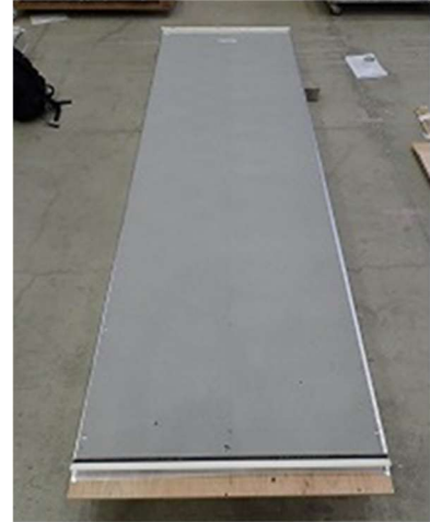
図 3-3-10 サイディング設置状況
