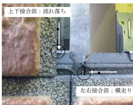
図 2-2-10 4方サネの浸入経路
