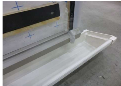
図 3-2-4 集水升の状況
