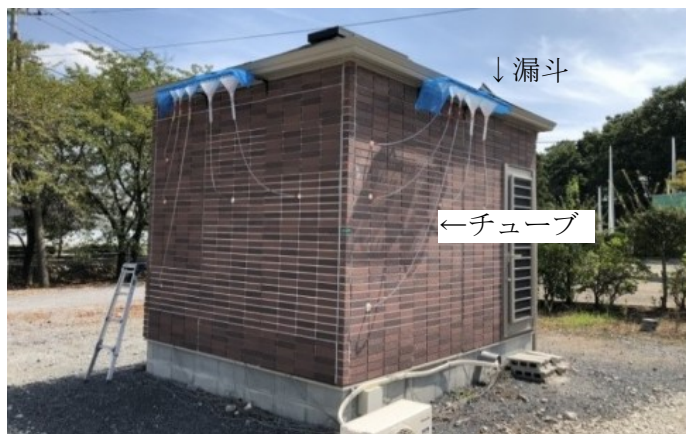
図 4-2-1 実験棟の外観、及び注水用漏斗とチューブの設置状況
